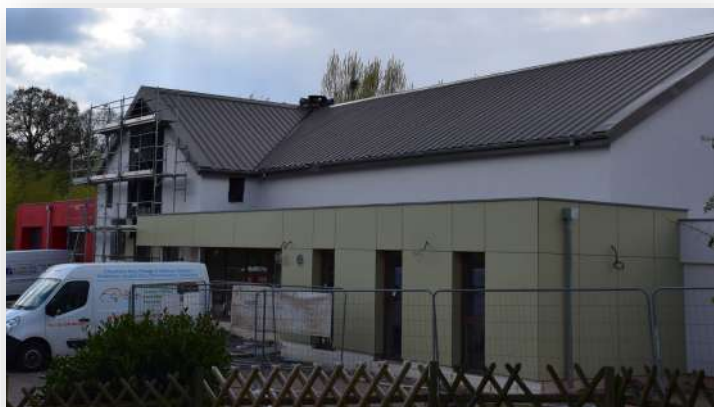
La fin des travaux est attendue pour la mi-septembre
