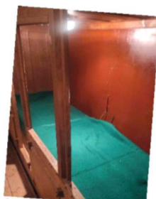
AVANT ISOLATION DU MUR EXTERIEUR
