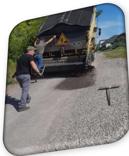
Les trous de la voirie causés par l'hiver, ont été rebouchés par la société ALVAREM
